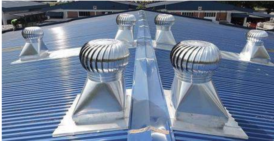
Gambar 29. Sirkulasi Udara dengan Turbo Ventilator
