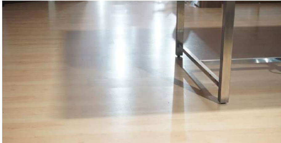
Gambar 35. Lantai Bengkel/Laboratorium yang Rata, Tidak Licin, dan Aman
